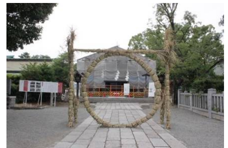
【大鳥大社(拝殿工事中)】
