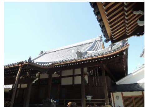
津久野町因念寺の本堂 (堺市で2番目に大きい木造建築)
