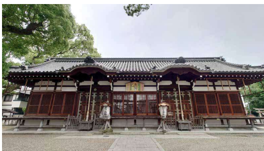
修復工事後の石津太神社の拝殿
